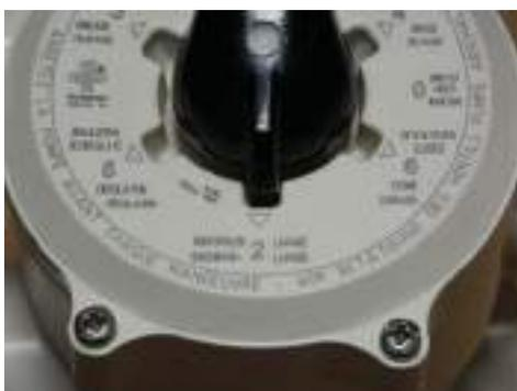
**В режиме промывки** фильтра схема движения воды выглядит следующим образом: вода из ванны подается насосом в фильтр, далее проходит обратным потоком через фильтр (снизу вверх) и сбрасывается в канализацию. При промывке фильтра, для избежании завоздушивания и выхода из строя (поломки) насоса, забор воды рекомендуется осуществлять через донные сливы ванны бассейна. В режиме промывки фильтра положение ручки вентиля показано на рисунке 6.
